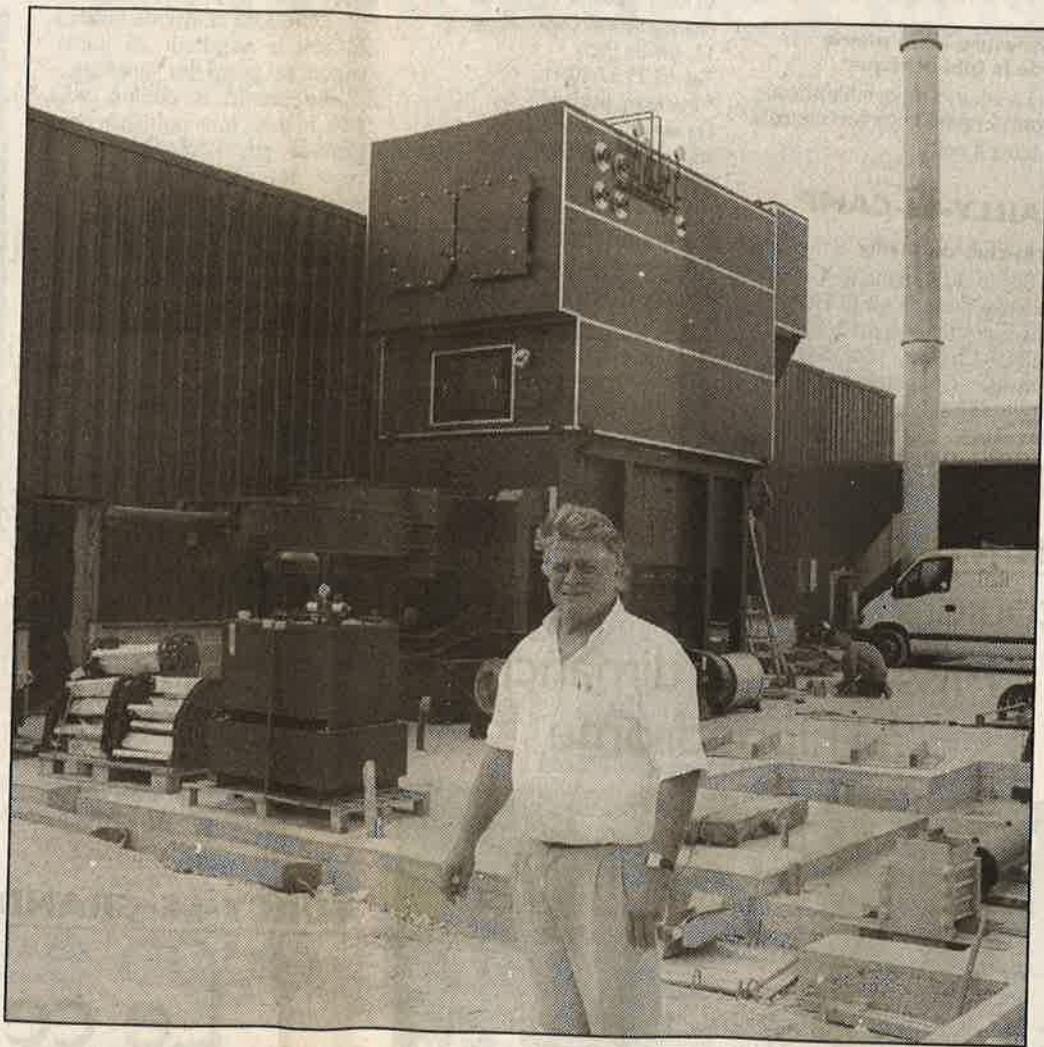
La nouvelle chaudière sera mise en fonctionnement le 15 septembre prochain
